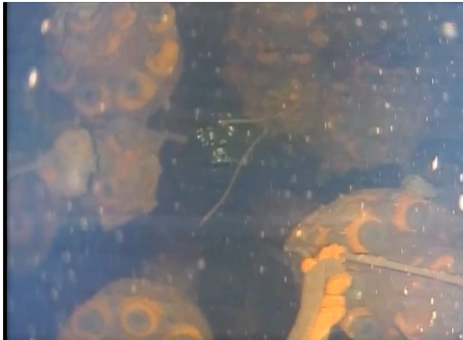
震災前のCRDハウジング支持金具の状態 (3号機)
